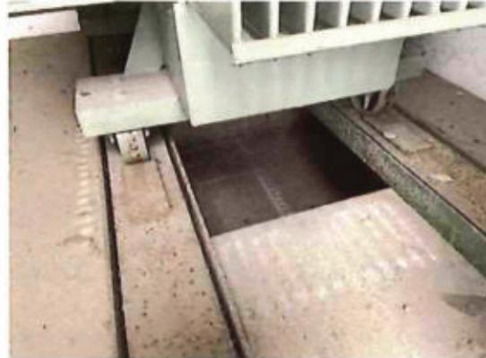
Abbildung 4: Betonwanne unter Trafo
