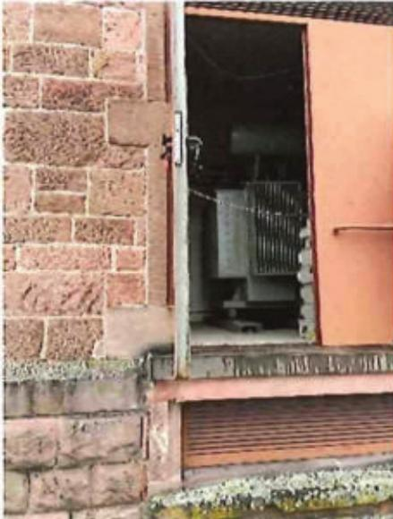
Abbildung 3: Trafo im EG mit Betonwanne, Trafo wurden PCB frei umgerüstet und zertifiziert
