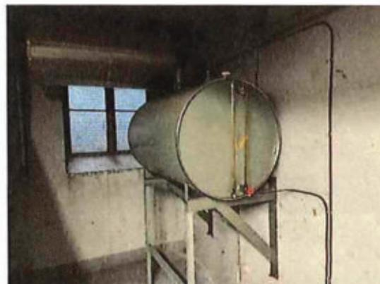
Abbildung 2: Dieseltank für Notstromaggregat
