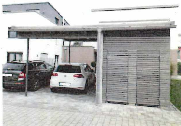
Carport mit Abstellhütte
