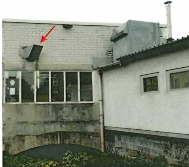
Abbildung 4-2: Ausblasung der Fortluft des Edelstahlschweißens (roter Pfeil)
